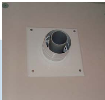
Monter le raccord de cheminée concentrique Duo
