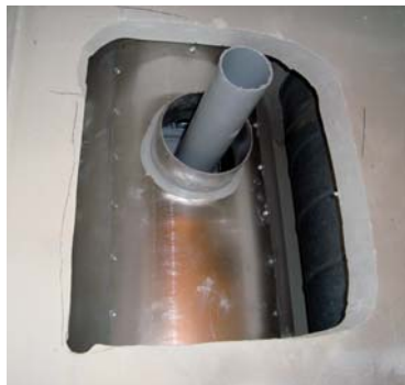
Raccorder le tuyau de fumée PP lisse au T MultiFlex
