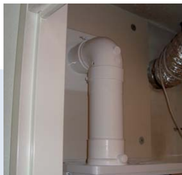
Raccorder la chaudière HR avec le matériel d'évacuation PP concentrique 60/100 mm de Burgerhout
