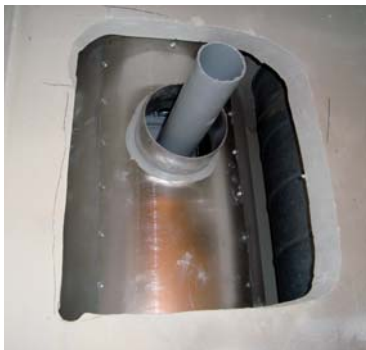
Rookgaspijp Ø 60 mm plaatsen op T-stuk
