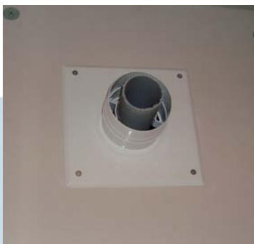
Concentrische schacht- aansluiting Duo monteren
