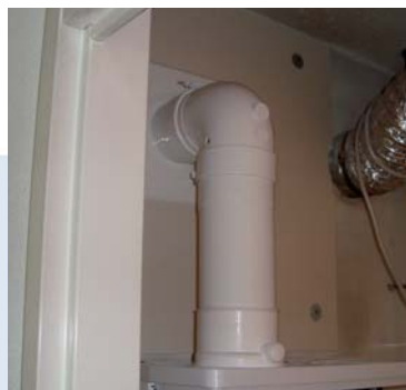
HR-ketel aansluiten met Burgerhout 60/100 mm PP concentrisch rookgasafvoermateriaal
